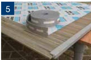
5 Selle ambos extremos de la plancha para evitar filtraciones. Para sellar el extremo superior utilizaremos cinta de aluminio más cubrezócalo.
