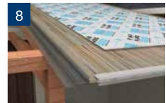
8 Para mantener la estanqueidad de los alveolos y evitar filtraciones, las planchas no se deben perforar. Para unir las entre sí, se utiliza el perfil HCP.
