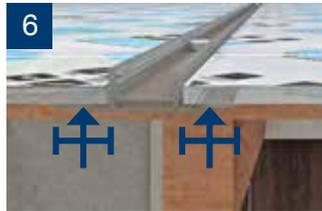
6 Coloque la plancha encima de los cantos de apoyo del perfil de base instalado, con el lado con filtro UV hacia el exterior.
