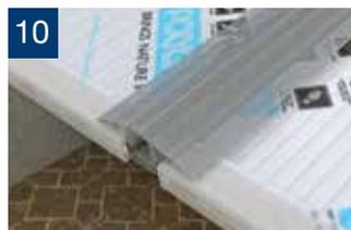
10 Para sellar el extremo inferior utilice cinta Filter Tape perforada.
