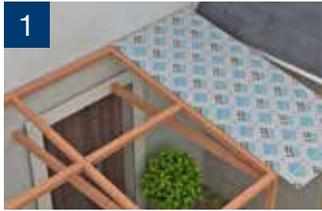
1 Instale la plancha con la película protectora que indica el lado con Filtro UV, hacia el exterior.
