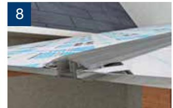
8 Para concluir la instalación, conecte la tapa del perfil HCP Clip a la base, martillándolo con un mazo de goma.
