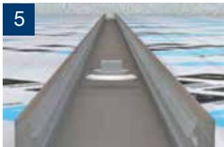
5 Utilice tornillos para fijar la base del perfil HCP CLip a las costaneras del techo. Asegúrese que los tornillos no ejerzan demasiada presión sobre el perfil.
