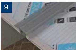
9 Para evitar filtraciones, selle los extremos superior e inferior de la plancha.
